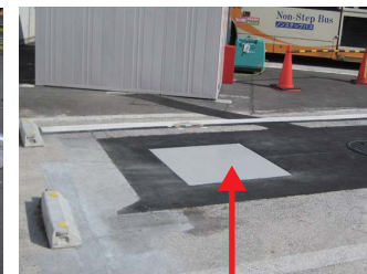
耐荷重型樹脂コンクリート製 送電コイル (晴美埠頭実証実験風景)
